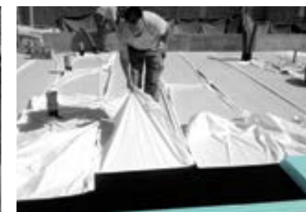
Poco a poco, retiramos el papel protector de la membrana de impermeabilización autoadhesiva de doble cara FIBRANhydro SEISMIC T-1,8 sk/sk y aplicamos las placas FIBRANxps
