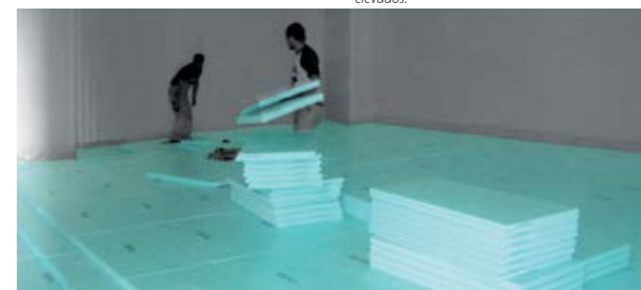
Las placas de aislamiento térmico FIBRANxps 300-L con esquina recta se utilizan en aplicaciones de múltiples capas.
