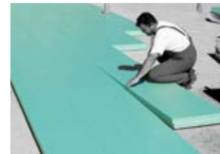
Antes de proceder a la colada de hormigón y a la aplicación de la primera capa de aislamiento FIBRANxps (400-L, 500-L ou 700-L) se debe prestar especial atención a las instalaciones.
