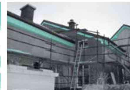
Aleros del tejado revestidos con FIBRANxps ETICS . El grosor depende del tamaño del voladizo del
