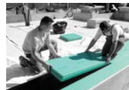
Las placas de FIBRANxps SEISMIC se aplican cuidadosamente sobre la superficie autoadhesiva de la membrana de impermeabilización.
