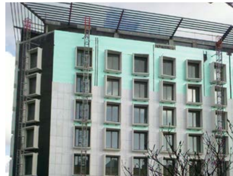
Revestimiento de piedra en un edificio de hotel con aislamiento resistente a la carga FIBRANxps ETICS BT , en el cual la piedra natural se fija mediante un procedimiento especial.
