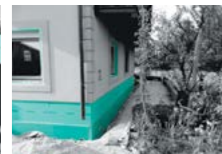
Corrección de los puentes térmicos existentes en el espacio de las ventanas y puertas, y aislamiento térmico del zócalo de la fachada con FIBRANxps
