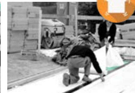
Sobre la sólida capa horizontal de aislamiento térmico, aplicamos la membrana autoadhesiva en ambas las superficies FIBRANhydro SEISMIC T-1,8sk/sk.
