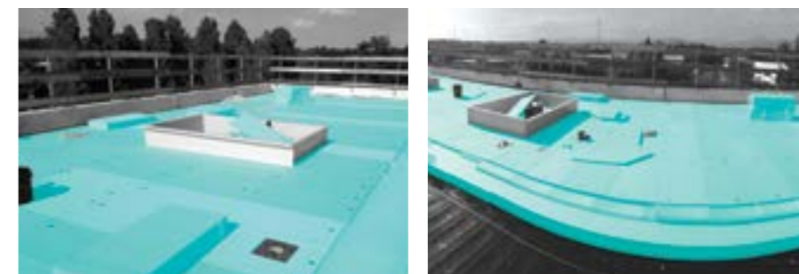
Aplicación de FIBRANxps INCLINE para obtener la inclinación correcta e instalación de FIBRANxps en la cubierta
