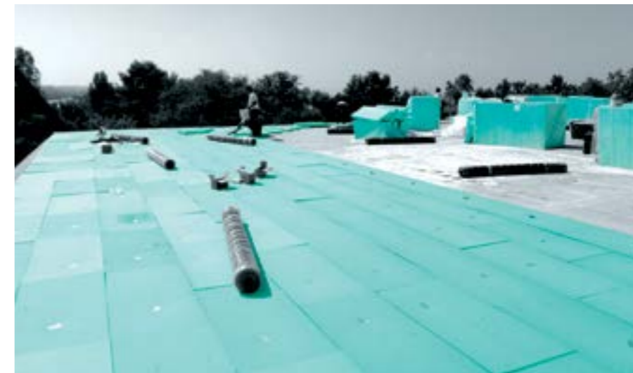
Aumento de la inclinación de la cubierta con FIBRANxps INCLINE y simultánea rehabilitación de la cubierta plana
