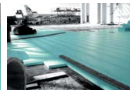
Protección térmica del piso de un hangar de aviones con FIBRANxps
