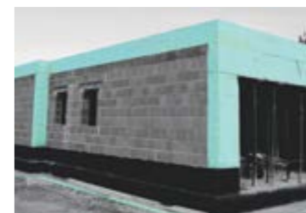
Aislamiento de los puentes térmicos de la viga con FIBRANxps ETICS
