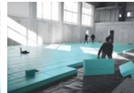
Aplicación de aislamiento térmico FIBRANxps 500-L debajo de una losa de cimentación de un edificio multifuncional.
