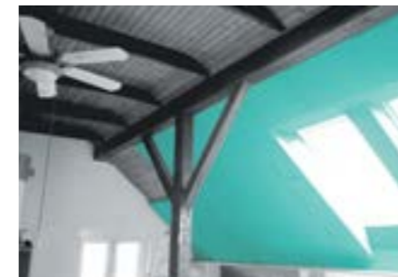
Aislamiento térmico desde el interior con FIBRANxps ETICS , superficie revestida con una capa fina de mortero adecuado y pintada.
